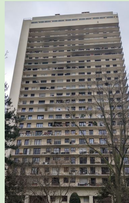
Le bâtiment IGH
