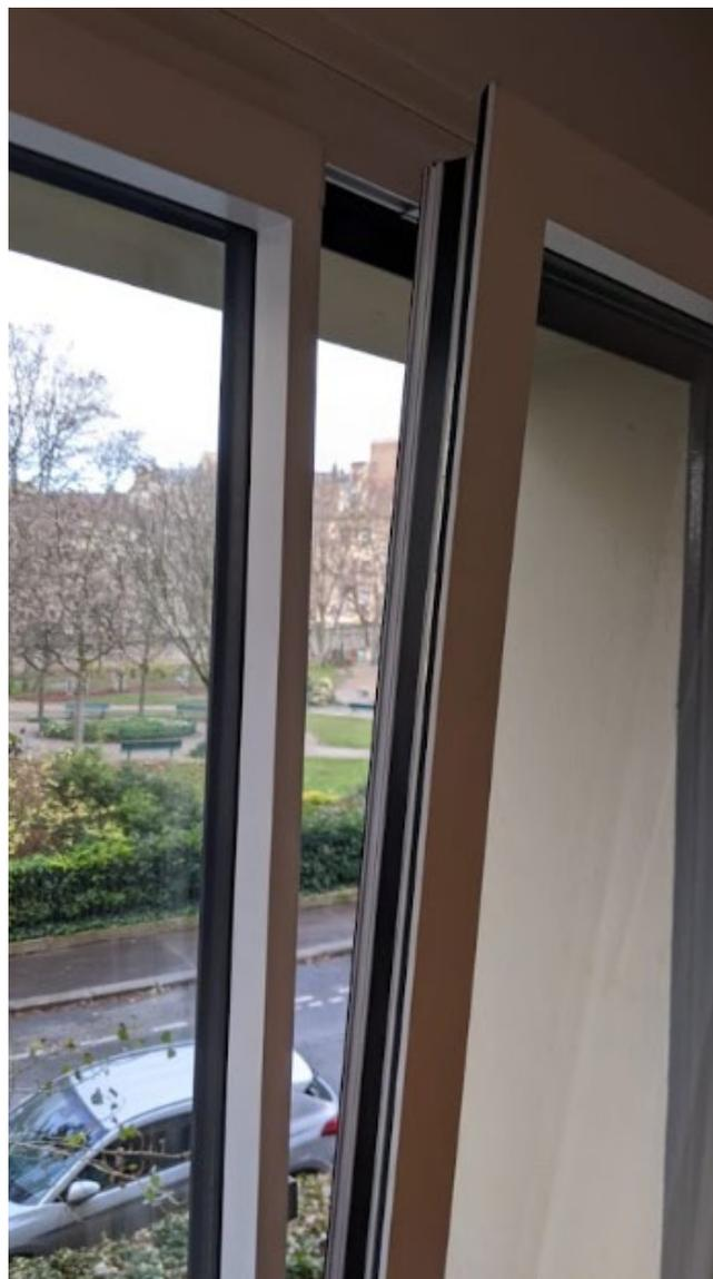
L'oscillo-battant est une fonction des fenêtres qui facilite l'aération
