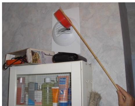
Photo n°29 : le « bouchon provisoire » de VMC
