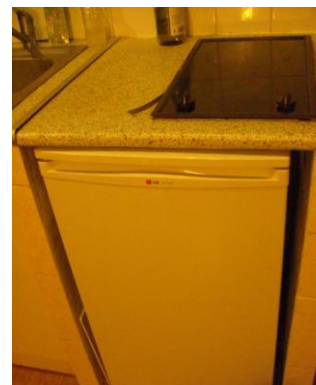
Photo n°7 : le réfrigérateur exposé à la chaleur
