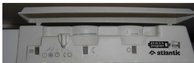
Photo n°40 : bouton de réglage thermostatique du convecteur
