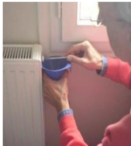
Photo n°38 : la purge « amateur » d'un radiateur
