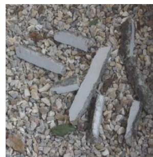
Photo n°48 : morceaux de béton tombés d'une façade
