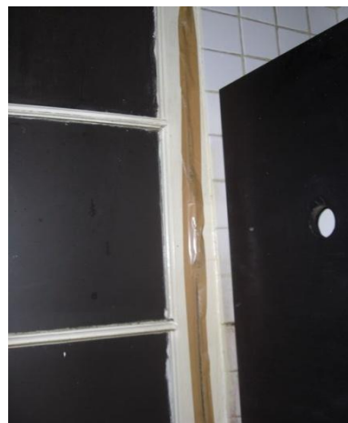
Photo n°30 : le scotch « isolant » la fenêtre
