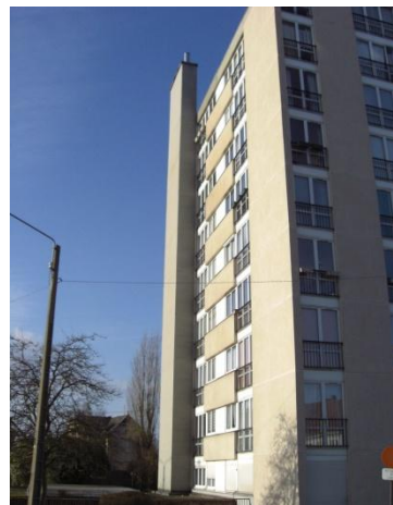
Photo n°34 : le conduit de la chaudière fioul à l'origine de « saleté »
