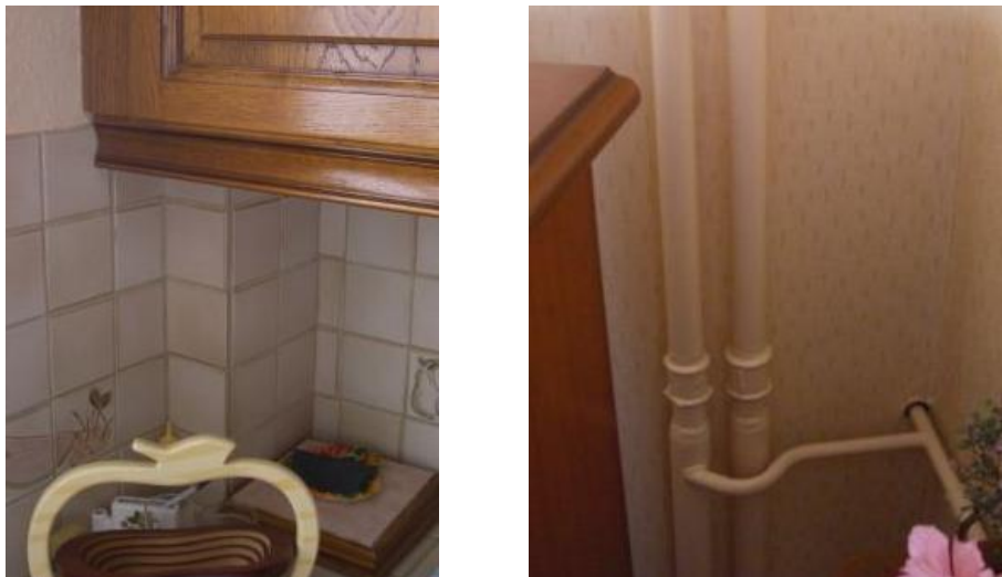
Photo n°33 : les tuyaux de chauffage hydraulique, entre le visible et l'invisible
