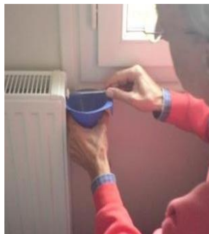
Photo n°38 : la purge « amateur » d'un radiateur
