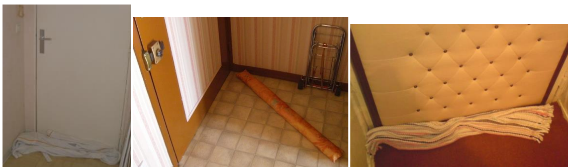
Photo n°32 : des tactiques de calfeutrage des portes d'entrée plus ou moins sophistiquées
