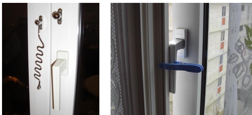
Photo n°28 : entrebâilleurs, intégré ou artisanal, facilitant l'aération continue
