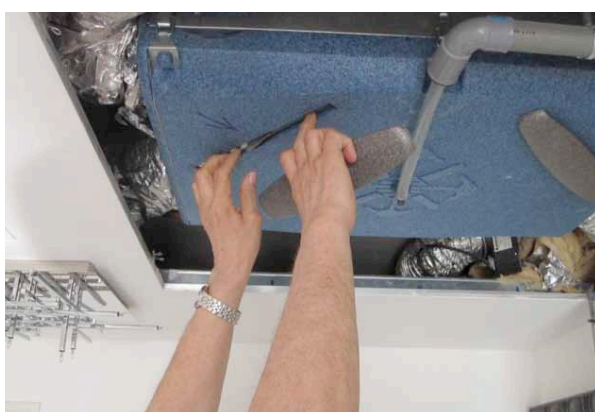
L'opération de retrait du filtre
