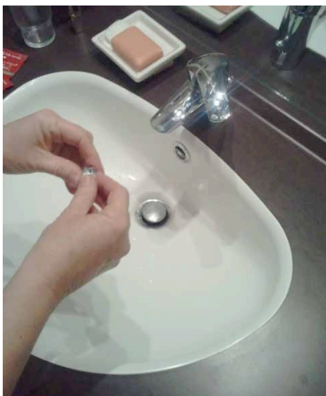
Le nettoyage des aérateurs
