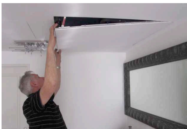
La trappe de ventilation dans le plafond
