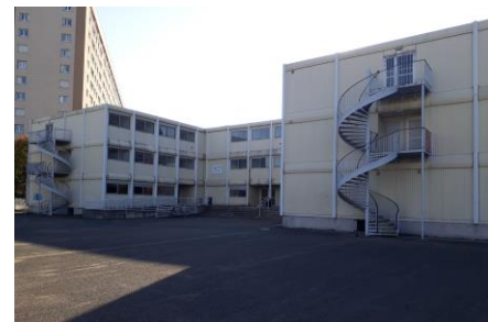
Un bâtiment modulaire provisoire “depuis 30 ans”
