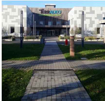
Un grand bâtiment rénové en 2007
