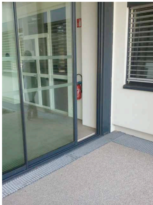
L'aération par le bas : porte d'entrée
