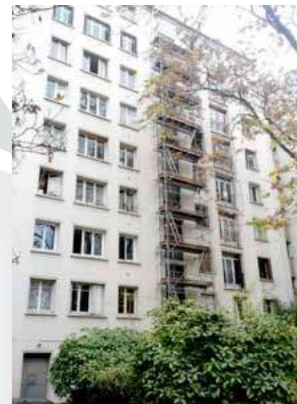
Façade sur cour de l'immeuble : vue sur la sapine permettant de monter l'isolant dans les combles © Gaëtan Brisepierre
